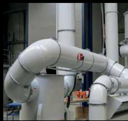
**Colliers d'assemblage en 2 pièces / Anillos tensores con masilla de sujeción, 2 piezas**
